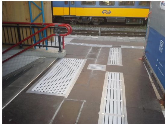
Schroef-en ring verbinding in plywood, met duct tape extra zijkanten getaped.
